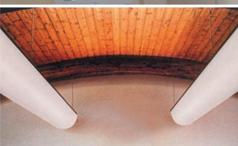
Per migliorare l'appassimento dell'uva si consiglia di utilizzare macchine nella versione alta velocità con l'applicazione di canalizzazioni in tessuto.
